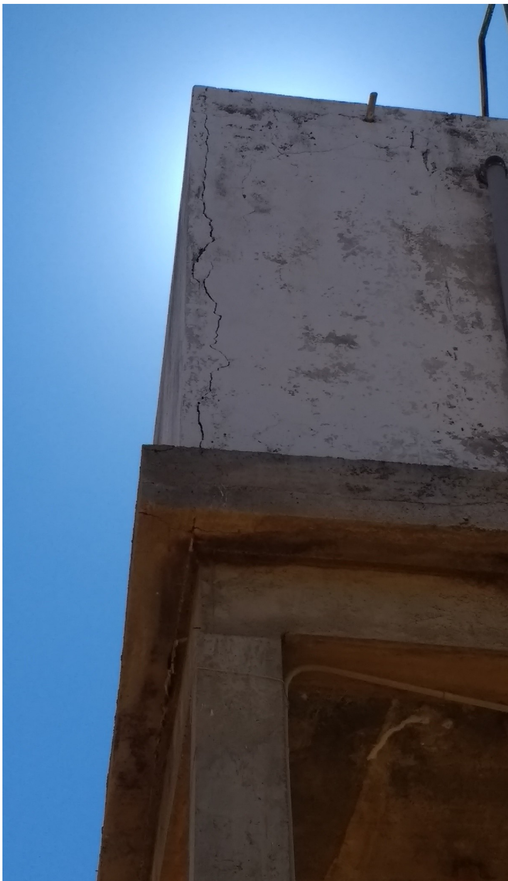
15 – Detalhe da caixa d'água com grande avaria.
