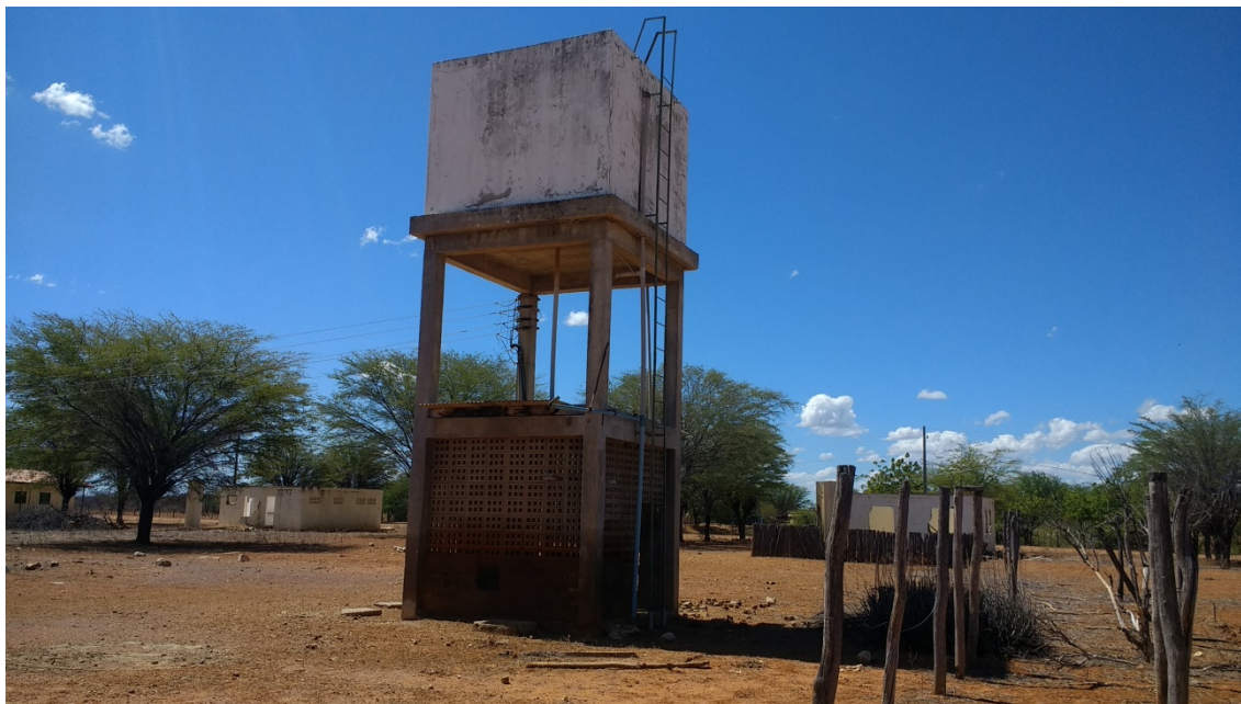
13-Detalhe geral da base com caixa d'água de 10.000 litros
