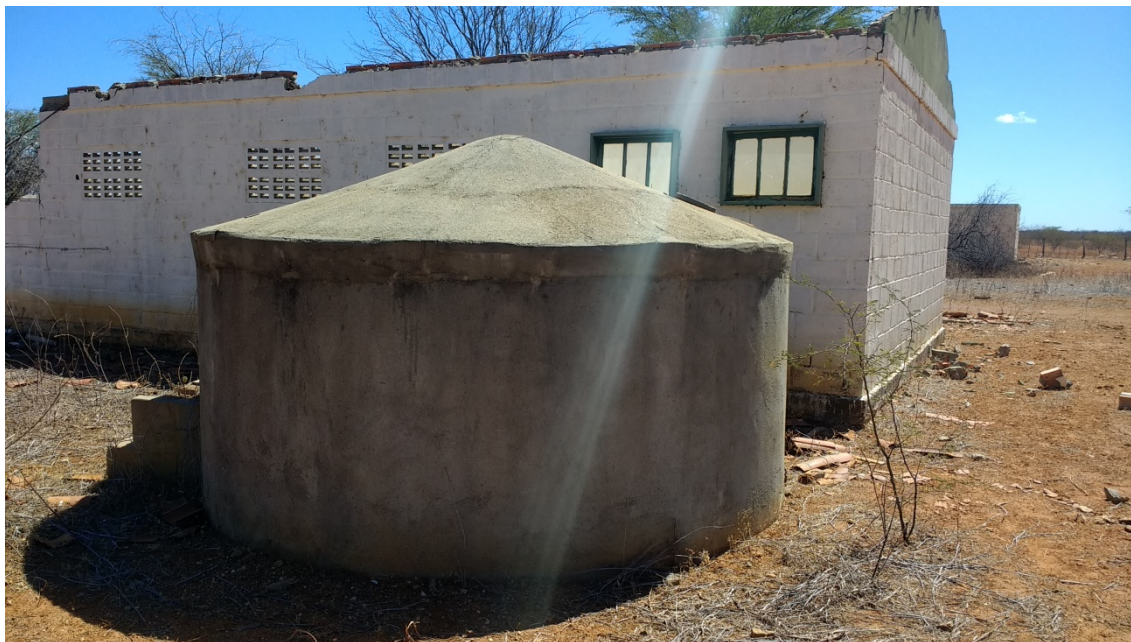
11-Detalhe da Cisterna de placa de 16.000 litros
