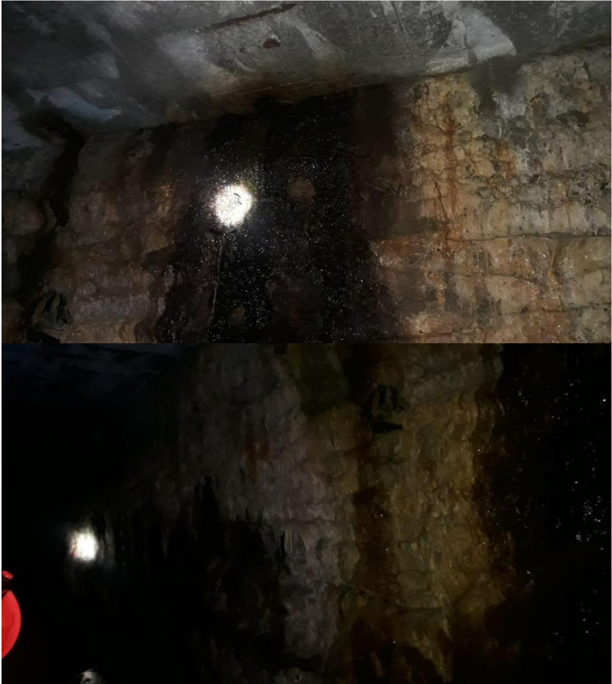
Figura 17 – Vazamentos e patologias - estrutura coberta de eflorescência
