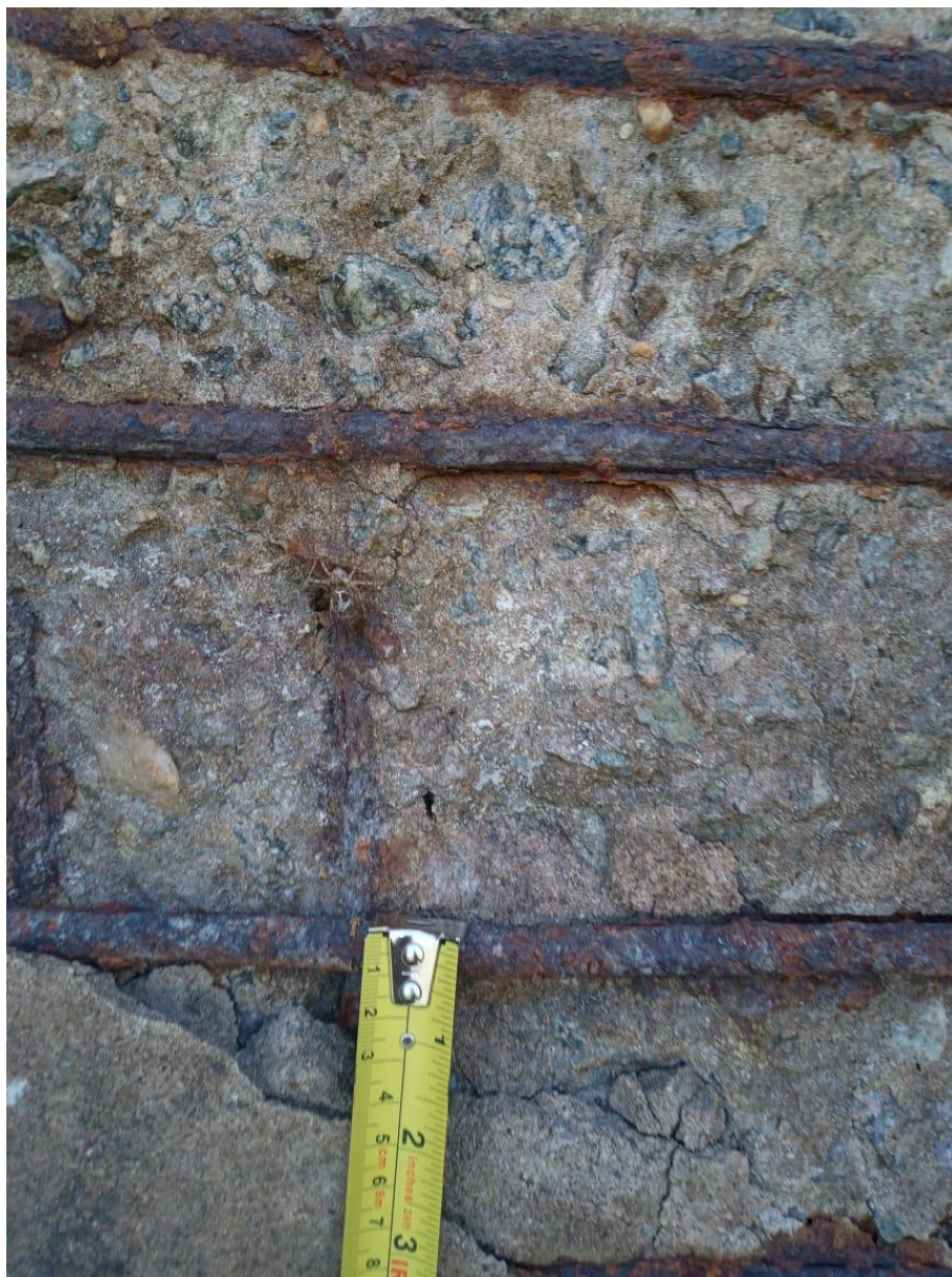
Figura 26 - Perda de secção da armação
