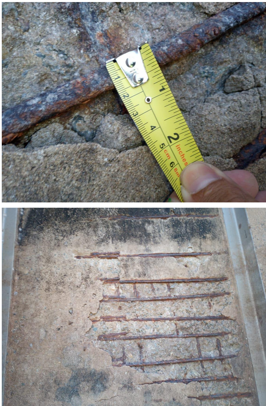
Figura 24 - Oxidação e perda de seção da armadura
