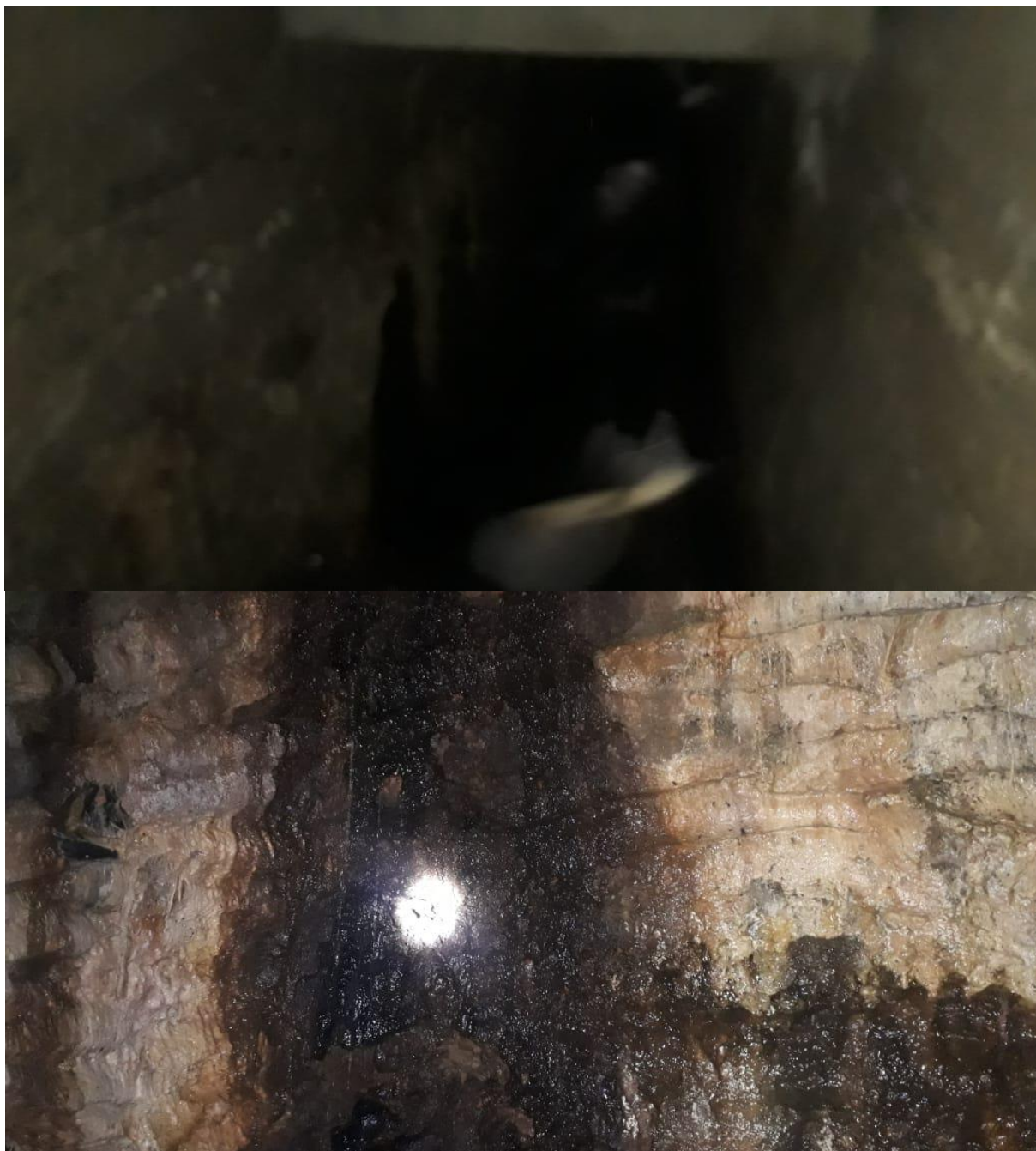
Figura 18 – Galeria de drenagem insalubre e vazamentos
