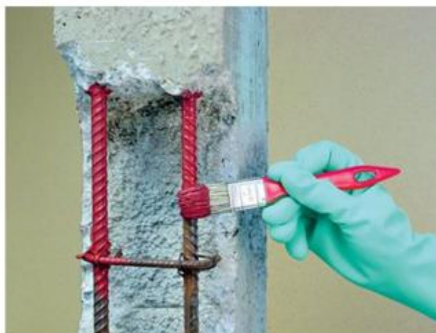
Figura 127 - Pintura de ferragens
