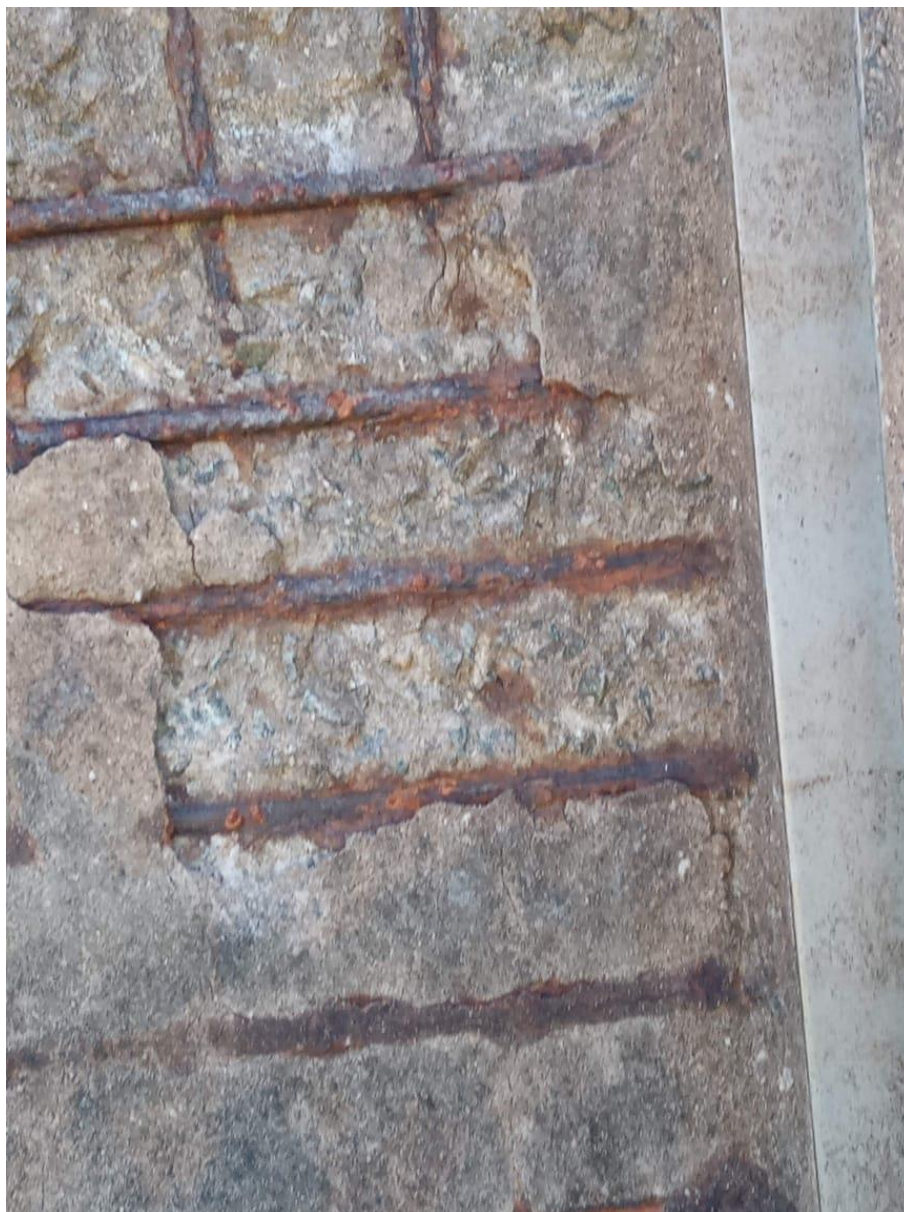
Figura 29 - Oxidação e destacamento
