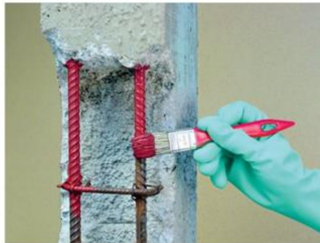
Figura 127 - Pintura de ferragens
