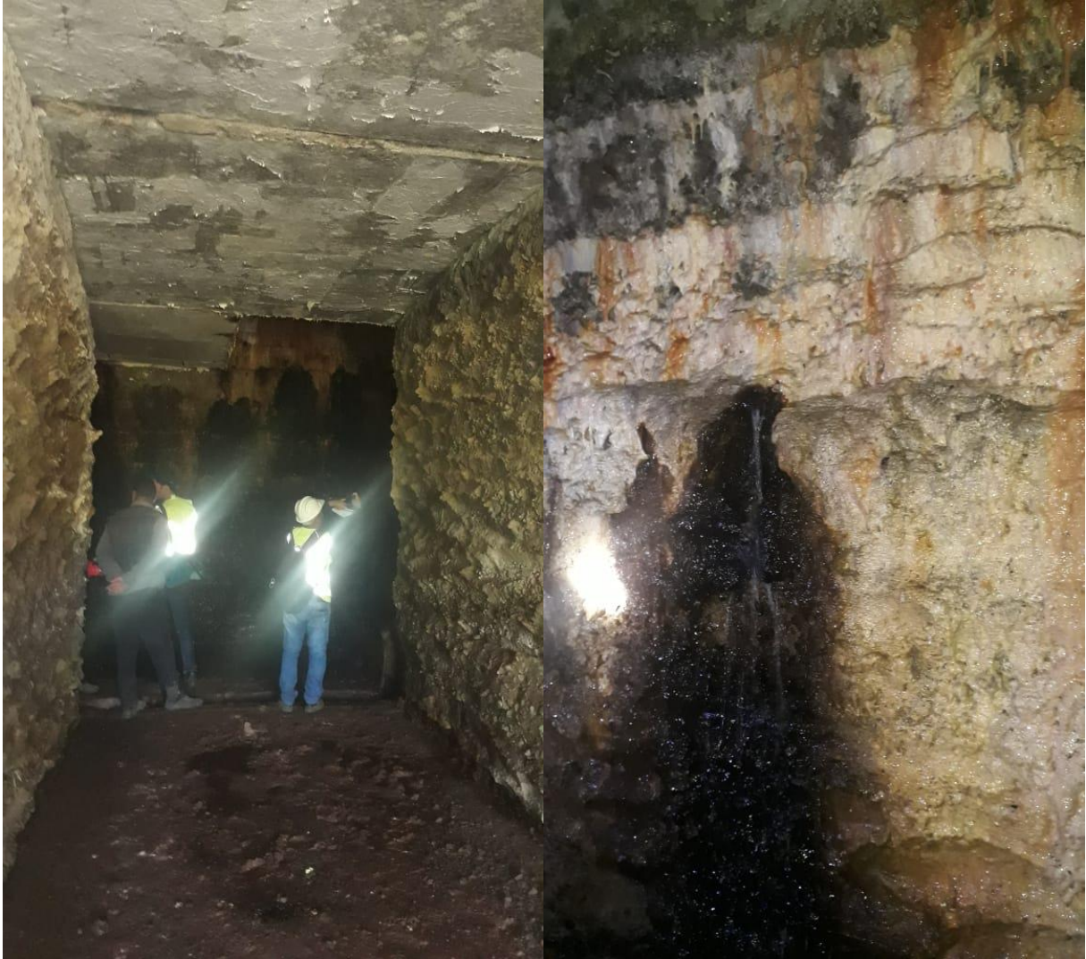
Figura 19 – Diafragmas coberto de eflorescência e vazamentos
