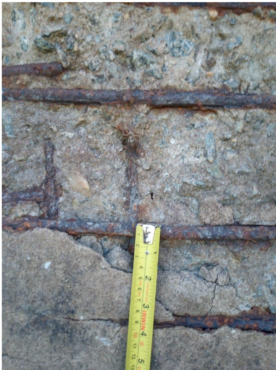
Figura 27 – Falta de cobertura gerado pelo destacamento da seção de concreto
