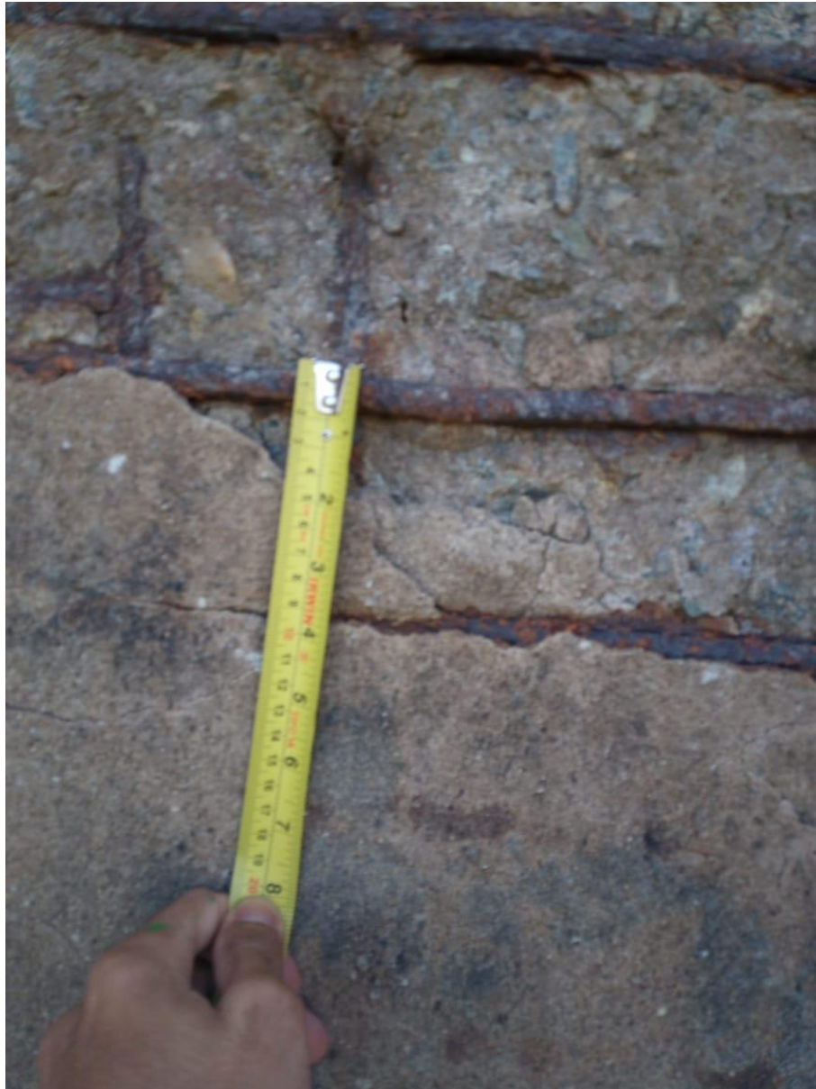
Figura 25 – Destacamento do concreto e perda de seção da armação
