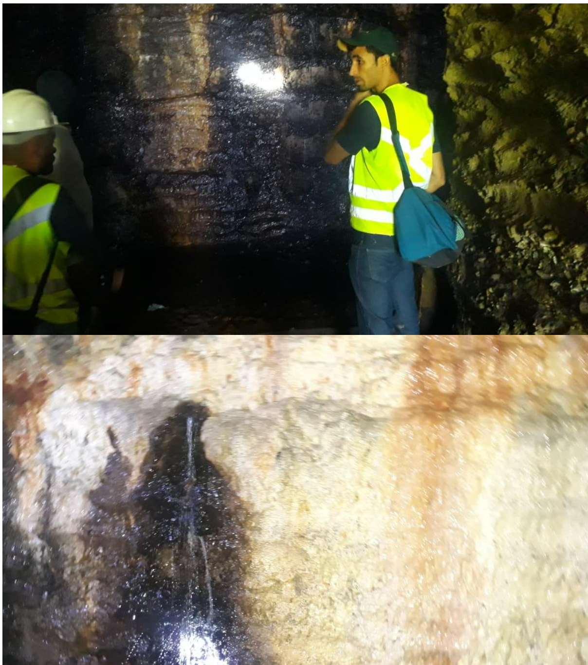
Figura 16 - Anomalias e falhas encontradas entre o acesso e a drenagem
