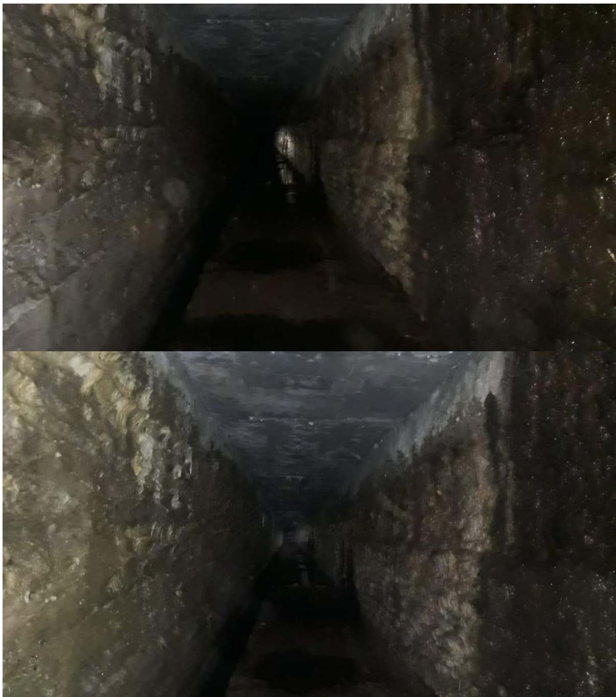
Figura 21 - Túnel da galeria insalubre, vazamentos e patologias
