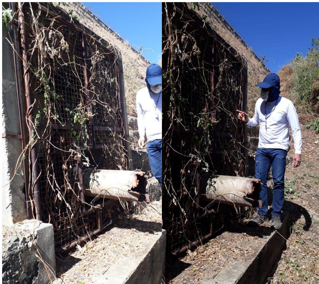
Figura 33 – Tubulação da válvula de alívio
