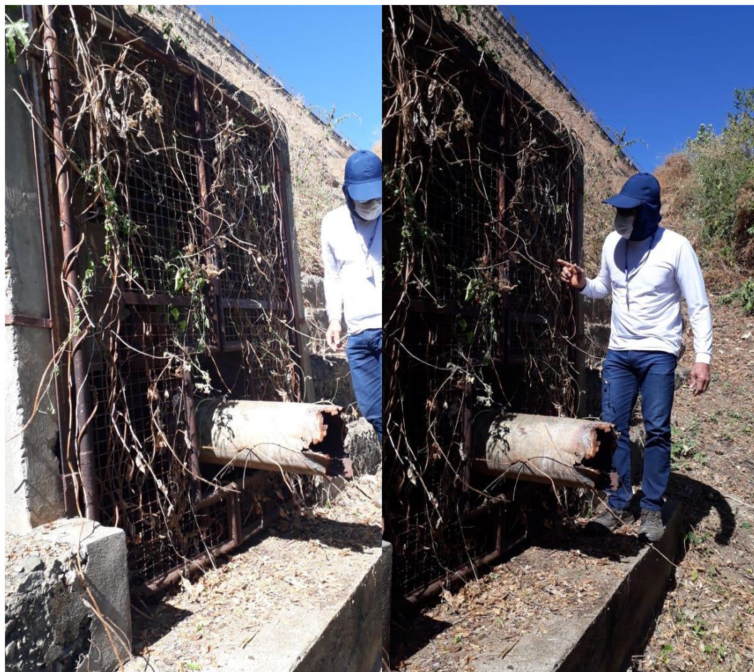
Figura 33 – Tubulação da válvula de alívio
