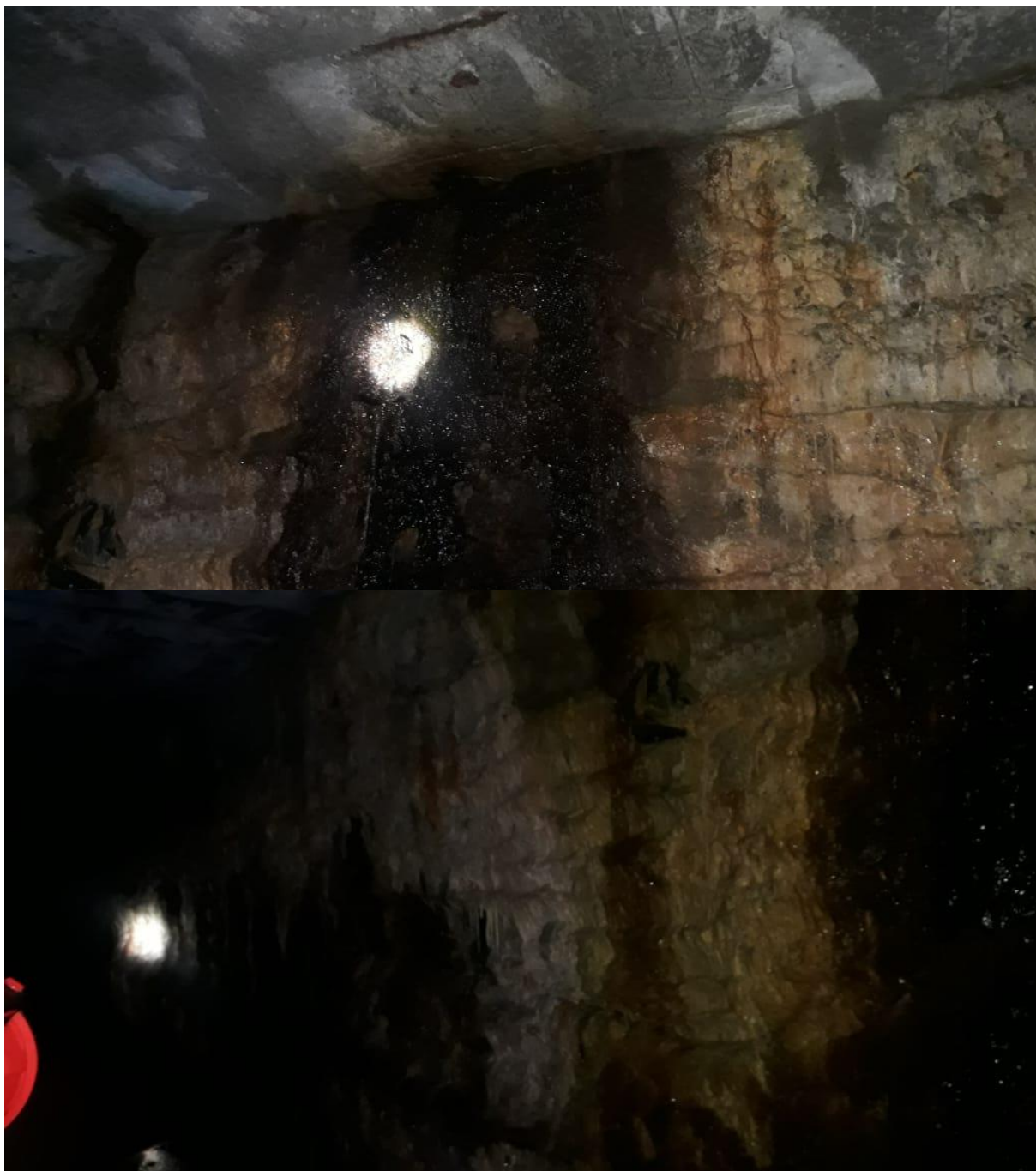
Figura 17 – Vazamentos e patologias - estrutura coberta de eflorescência
