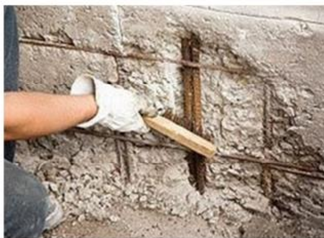
Figura 126 - Escovação de armaduras
