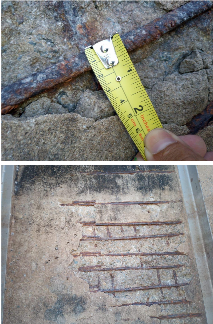
Figura 24 - Oxidação e perda de seção da armadura
