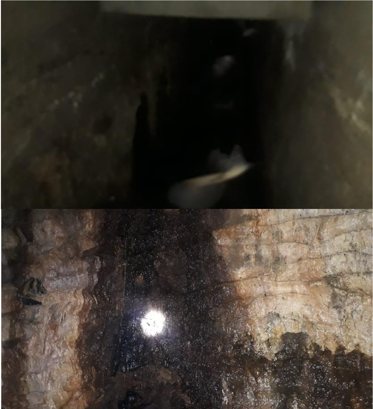
Figura 18 – Galeria de drenagem insalubre e vazamentos
