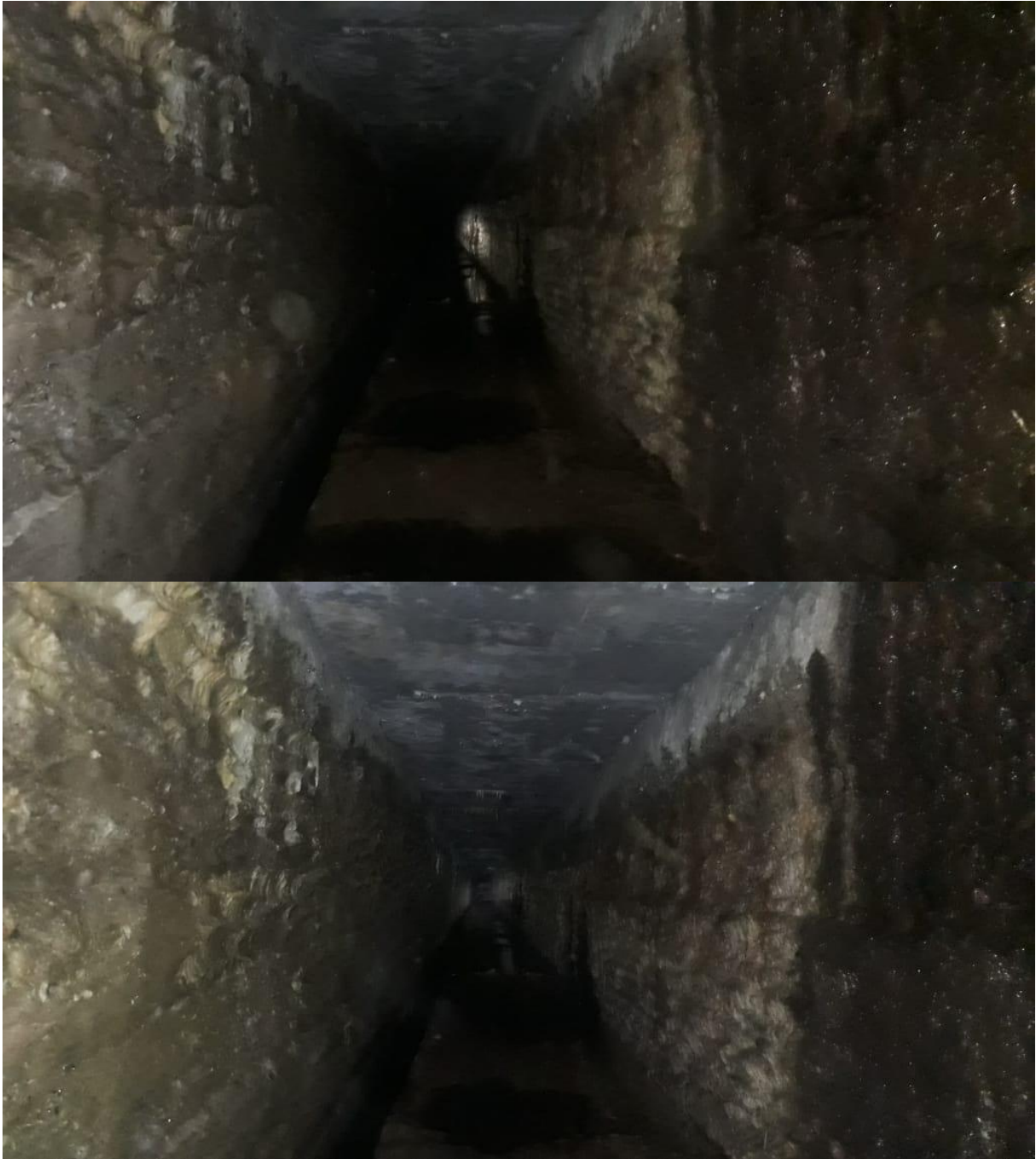
Figura 21 - Túnel da galeria insalubre, vazamentos e patologias
