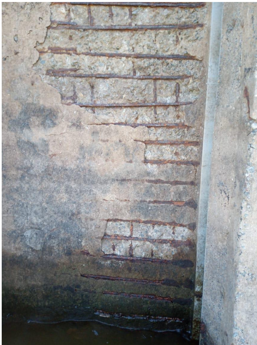
Figura 28 – Grande destacamento da secção de concreto
