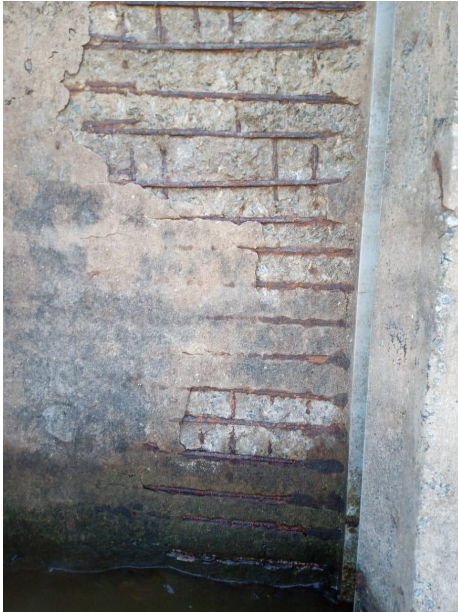
Figura 28 – Grande destacamento da secção de concreto
