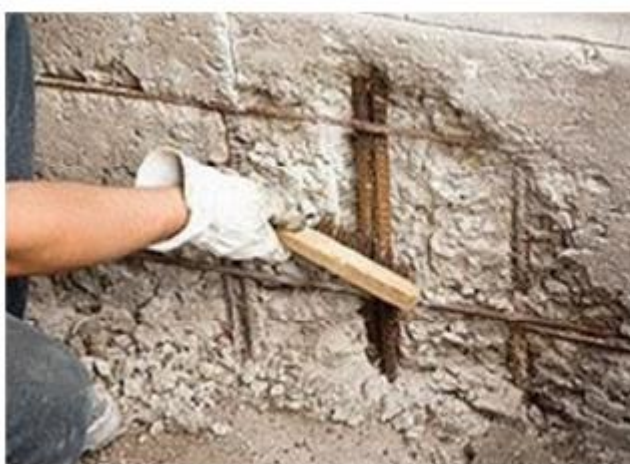
Figura 126 - Escovação de armaduras
