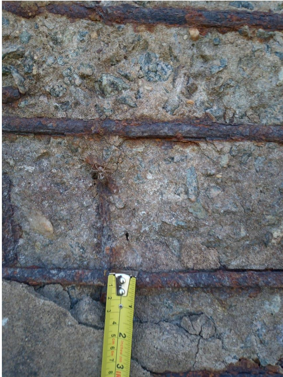
Figura 26 - Perda de secção da armação
