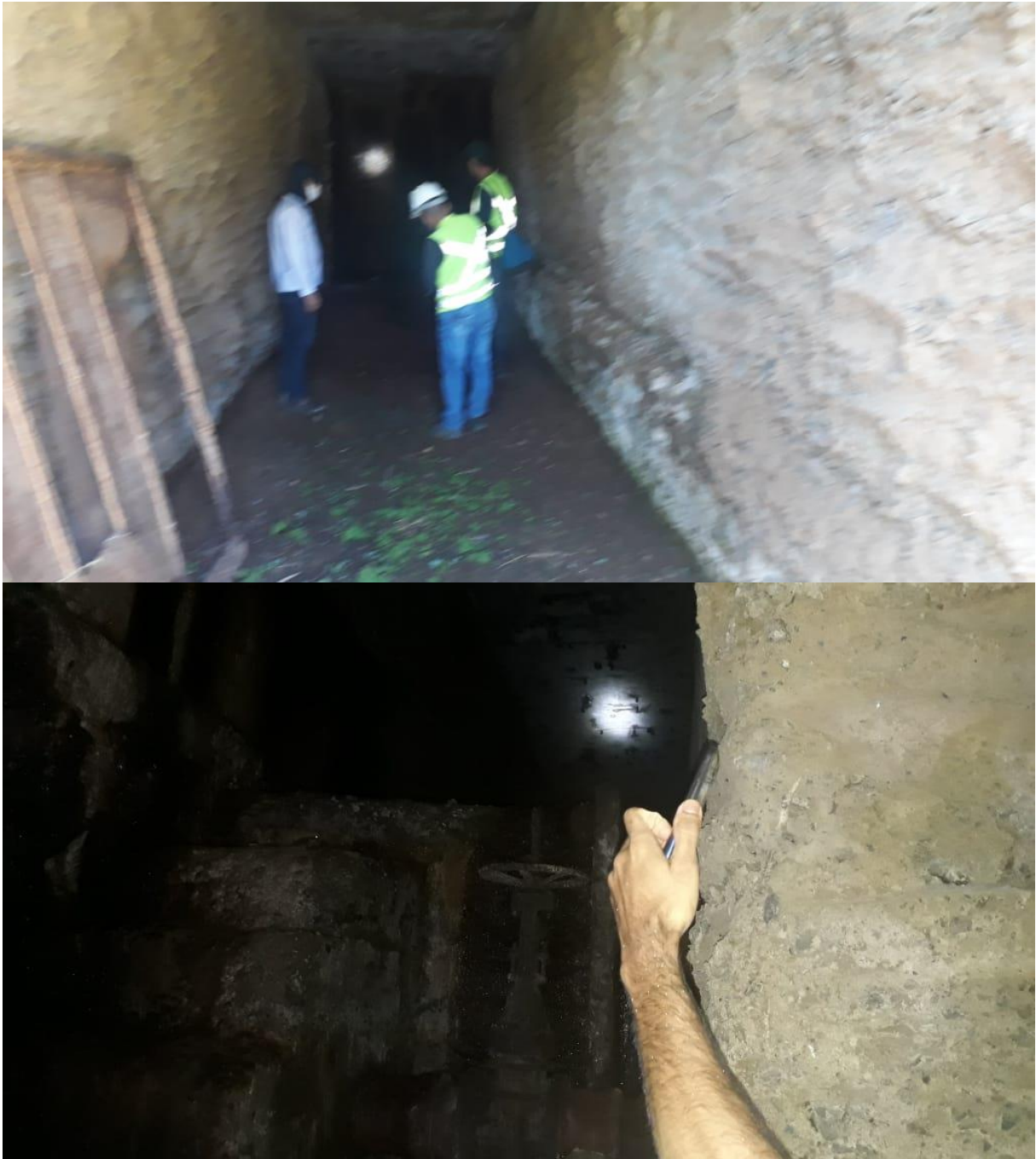
Figura 20 - Vegetação no túnel de acesso, registo de descarga oxidado
