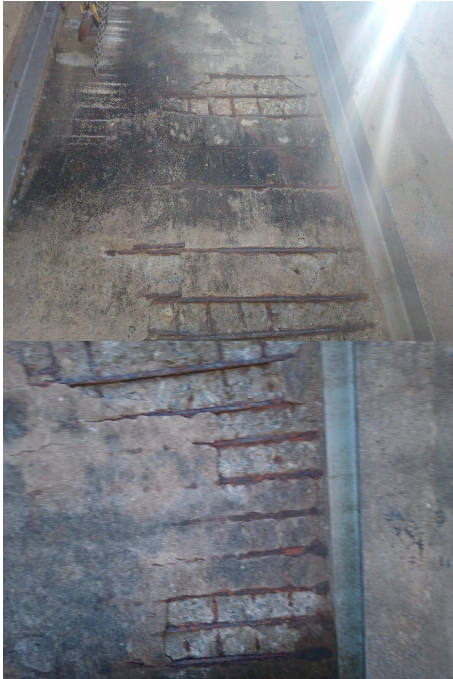
Figura 30 - Anomalias na galeria de tomada de água
