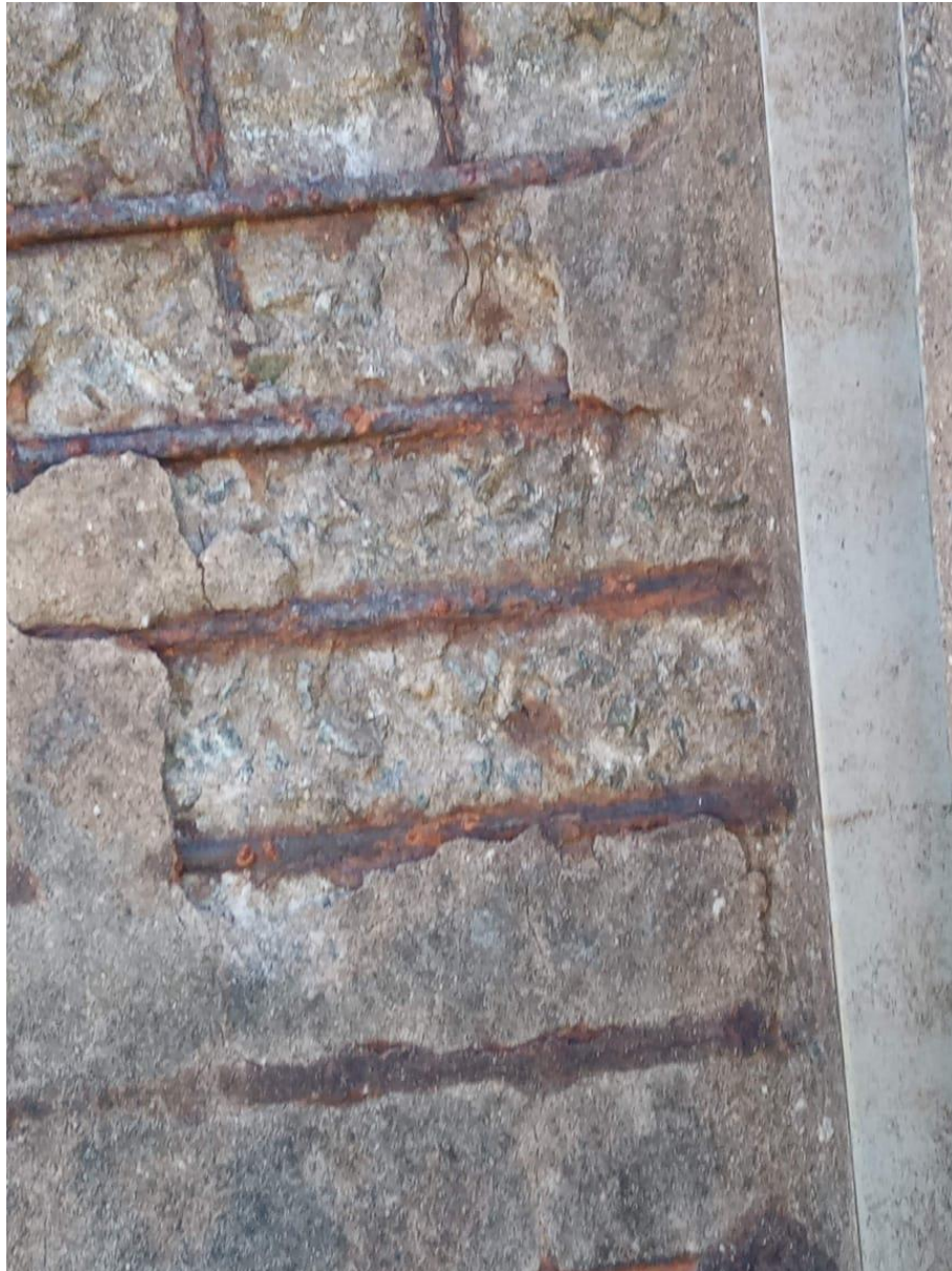
Figura 29 - Oxidação e destacamento
