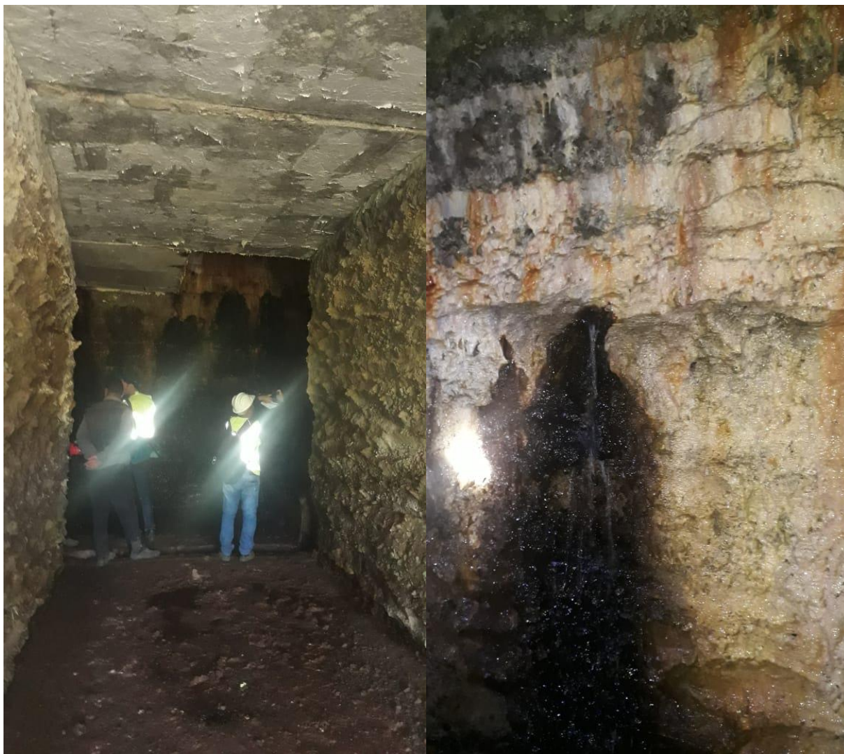
Figura 19 – Diafragmas coberto de eflorescência e vazamentos
