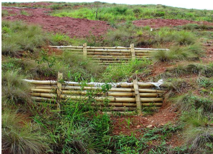
Figura 8: Paliçada construída com bambu. Fonte: EMBRAPA, disponível em: https://www.embrapa.br/busca-de-imagens/-/midia/2238004/palicada-de-bambu
