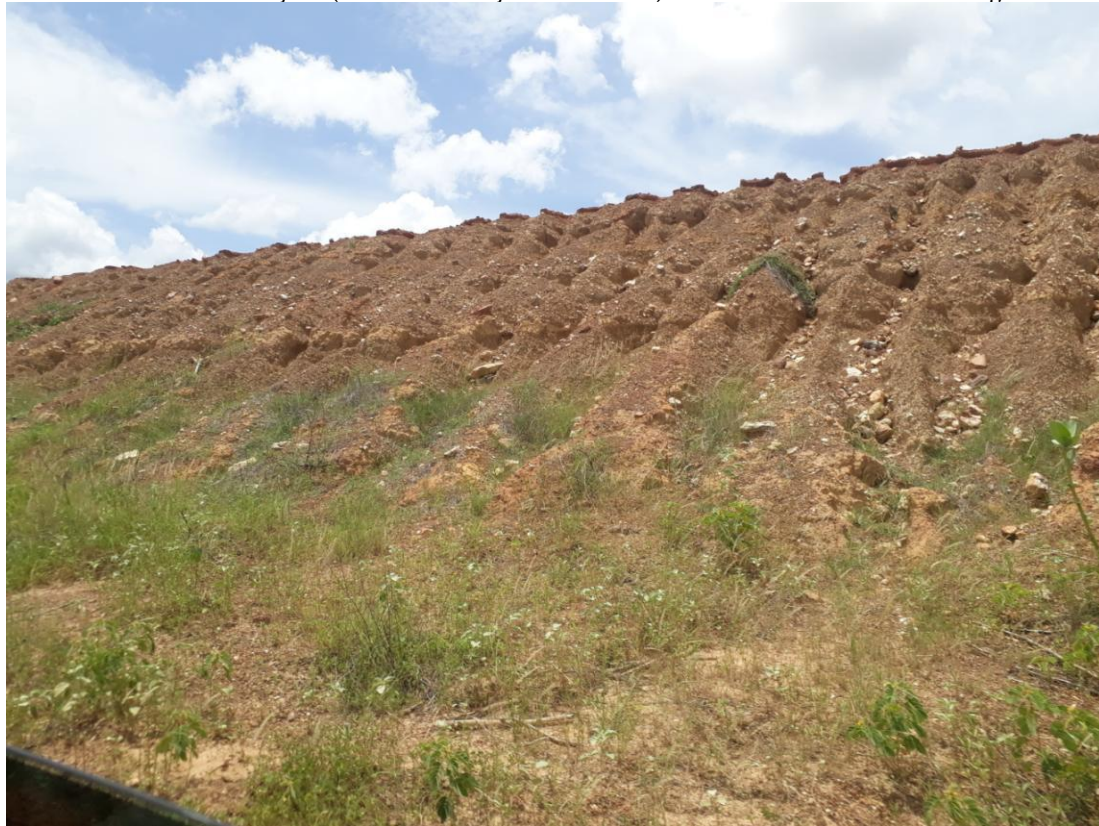
Figura 3 – Processo erosivo avançado (início de formação de cavernas) em taludes em recobrimento vegetal ou de pedras
