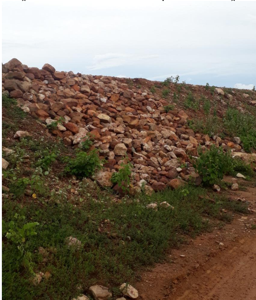
Figura 2 – Talude existe com enrocamento de pedras e cobertura vegetal
