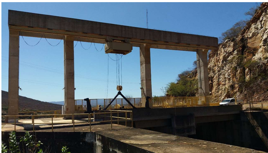
Foto 01. Vista geral dos equipamentos de acionamento das comportas segmento do vertedouro.
