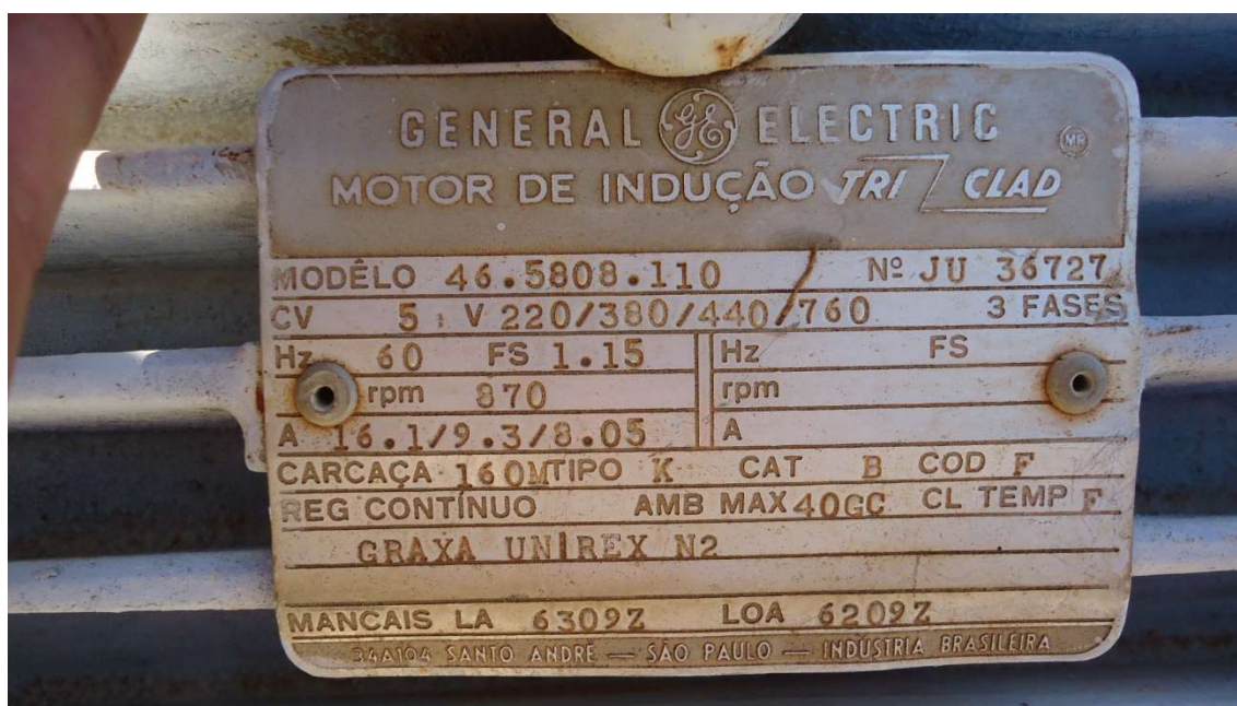
Foto 5. Plaqueta de identificação do modelo dos motores elétricos de acionamento dos conjuntos moto-redutor.
