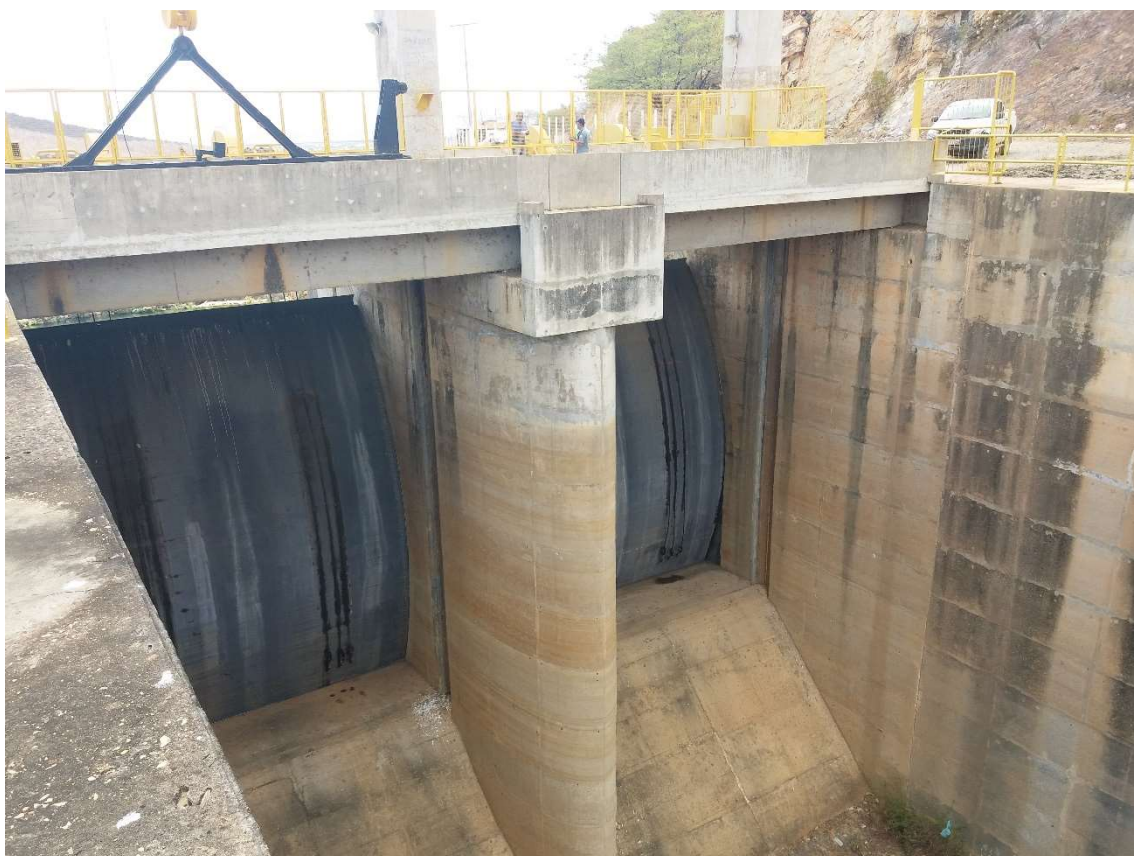
Foto 05. Imagens das duas comportas do vertedouro.
