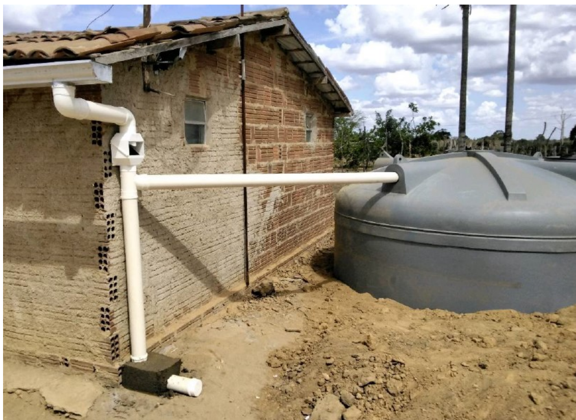
Figura 8: Visão geral da cisterna instalada.
