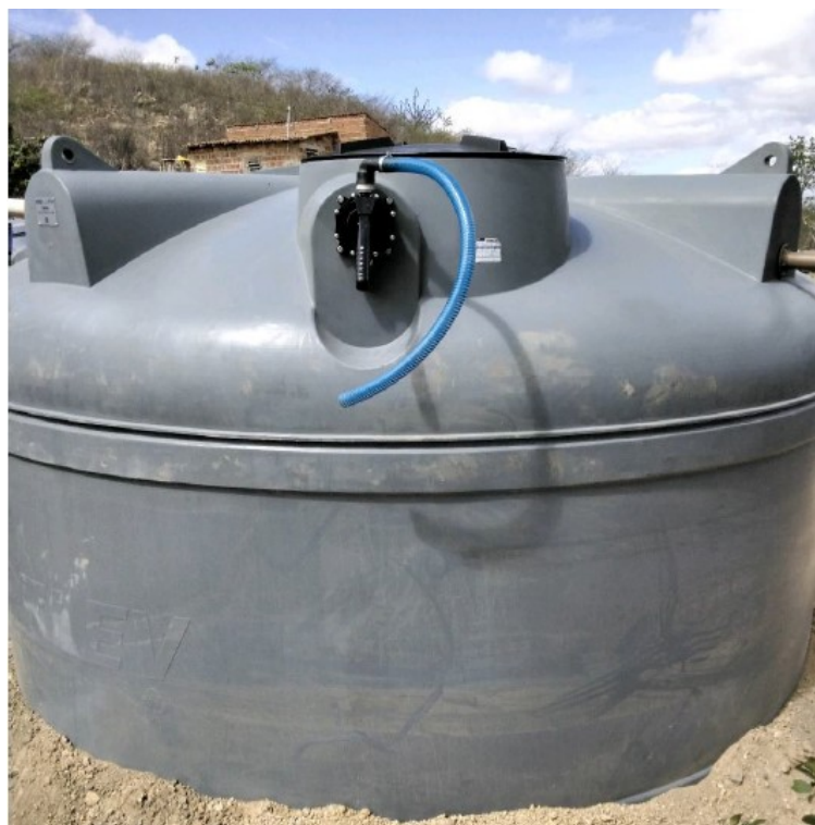
Figura 5: Exemplo de reservatório de 16.000L instalado.
