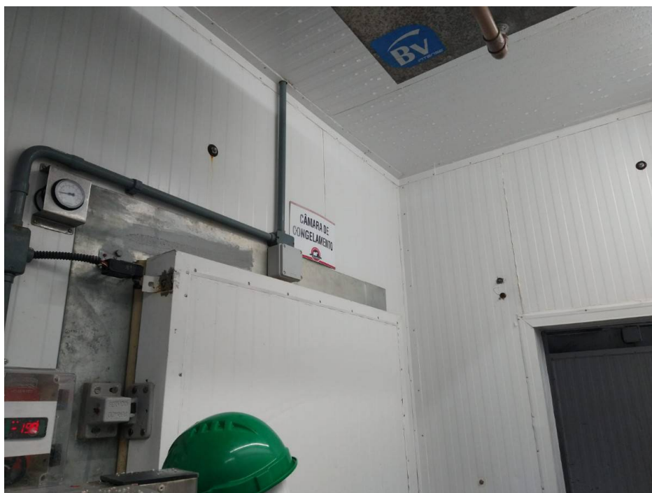
8. Túnel de congelamento em isopainéis, equipamento de frio com capacidade de 1.500 Kg/24 horas. Estado de conservação: Regular
