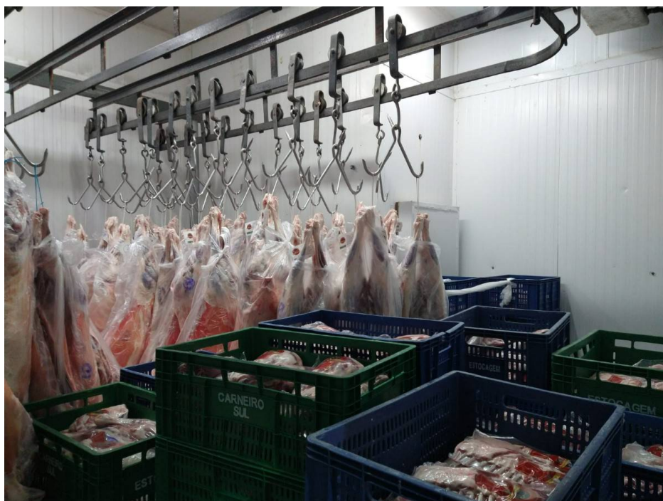
10. Câmara fria com capacidade de 150 carcaças, em isopainéis com conjunto de trilhos, equipamento de frio e uma porta do tipo de correr. Estado de conservação: Regular
