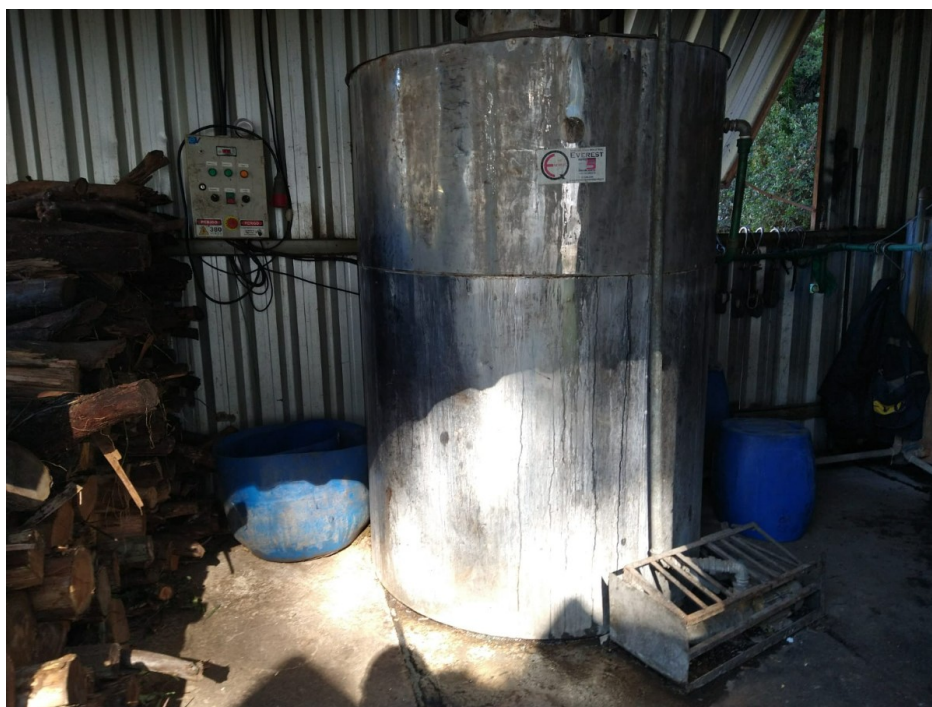
18. Boiler em aço inox para aquecimento de água a vapor. Estado de conservação: Reparos simples e importantes
