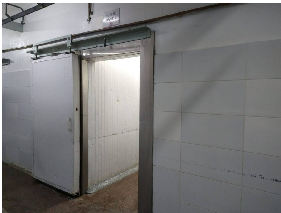
11. Sala de desossa em isopainéis com equipamento de frio. Estado de conservação: Regular
