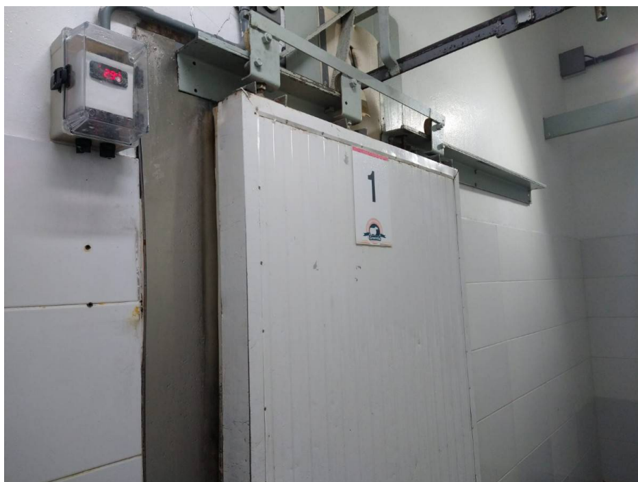
7. Câmara com capacidade para 100 carcaças, em isopainéis com conjunto de trilhos, equipamento de frio e duas portas do tipo de correr. Estado de conservação: Regular
