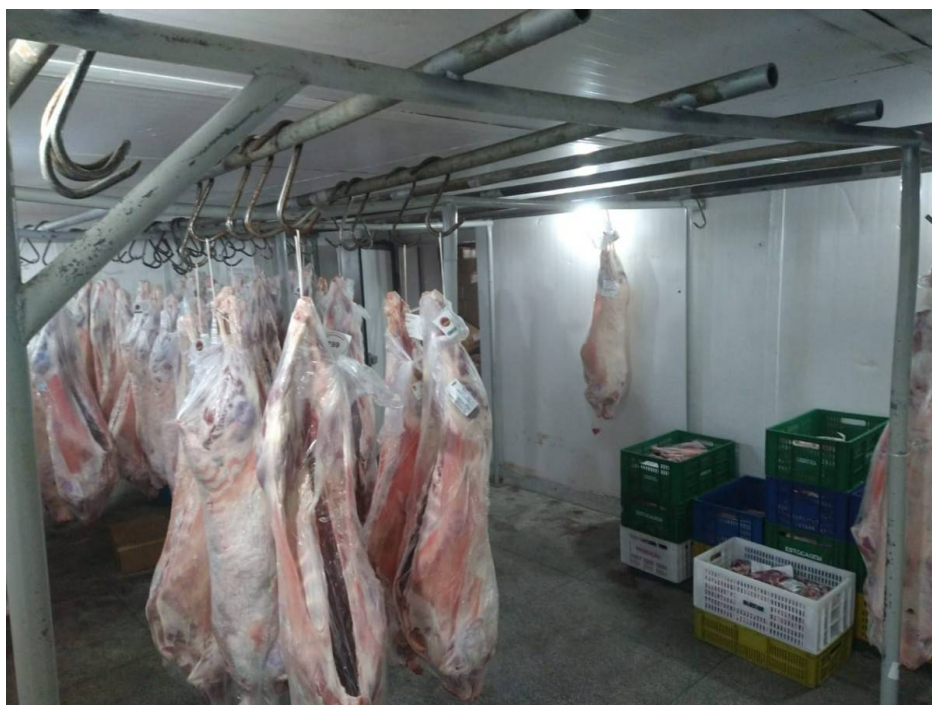
20. Duas câmaras para carcaças resfriadas com gancheiras, com capacidade para 200 carcaças cada. Estado de conservação: Regular
