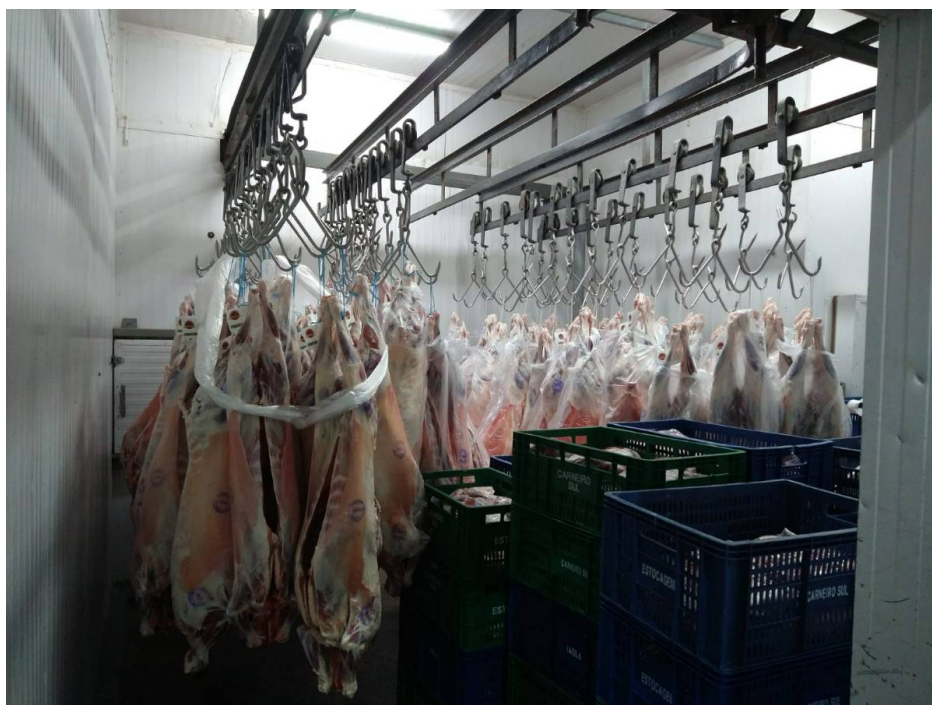
10. Uma câmara fria com capacidade de 150 carcaças, em isopainéis com conjunto de trilhos, equipamento de frio e uma porta do tipo de correr. Estado de conservação: Regular
