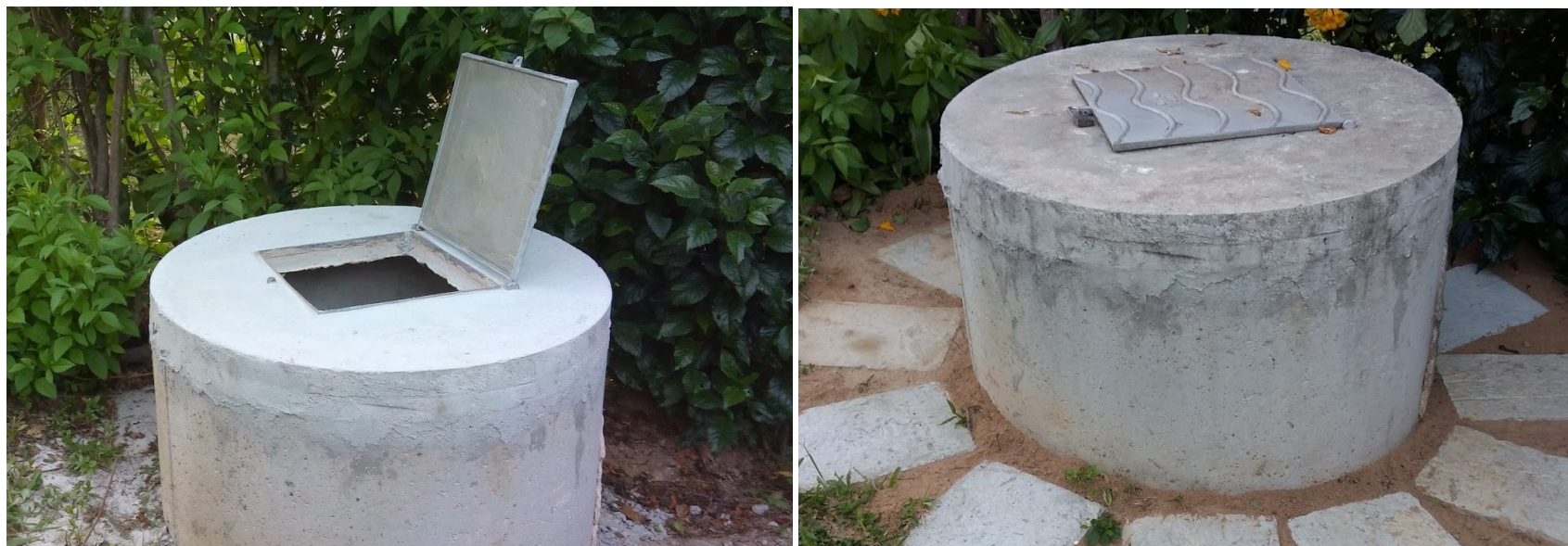
Figura 29: Exemplo de abrigo semelhante ao que deve ser construído nos sistemas de irrigação por aspersão malha fixa para área de 1,00 (um) ha (Itens 1 e 2), microaspersão para área de 0,50 ha (Itens 3 e 4), gotejamento para horta de 500 m 2 (Itens 5 e 6). No entanto, deve-se ressaltar a necessidade de substituir o anel de concreto representado nas imagens acima por um anel de concreto perfurado, para permitir a ventilação da bomba, bem como, deve-se confeccionar dois orifícios maiores em lados opostos do anel para entrada da tubulação de sucção e saída de bomba, respectivamente, e construir uma base/piso de concreto magro com 0,05 m de espessura para assentamento do anel e do conjunto motobomba, de acordo com as especificações técnicas descritas nos Itens 3.1.9, 3.2.9 e 3.3.8 desse anexo. As imagens acima servem apenas para ilustrar o abrigo do conjunto motobomba, devendo prevalecer as especificações técnicas descritas nos Itens 3.1.9, 3.2.9 e 3.3.8 desse anexo. Fonte: Ronaldo Montechiare, 2018. Disponível em: http://ronaldomontechiare.blogspot.com/2018/11/abrigo-para-bomba-dagua-feito-com.html . Acesso em: 06 set. 2022.
