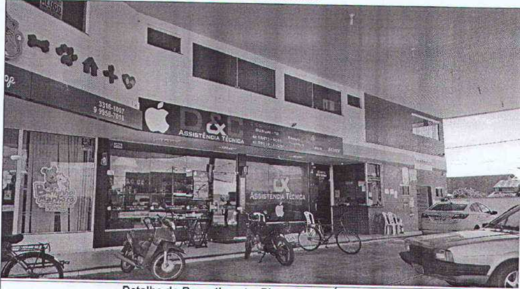
Detalhe do Revestimento, Piso e Forro (Área externa)
