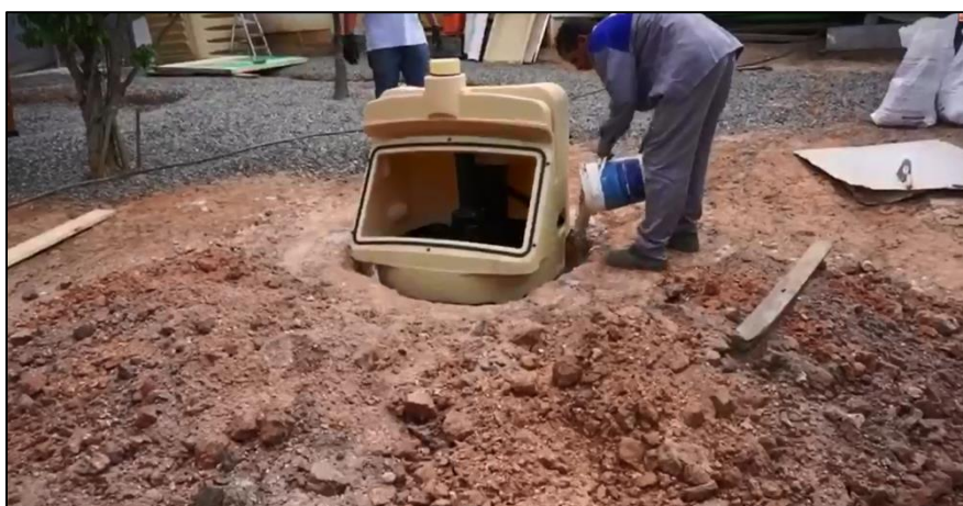
Reaterrar a lateral da unidade funcional.
