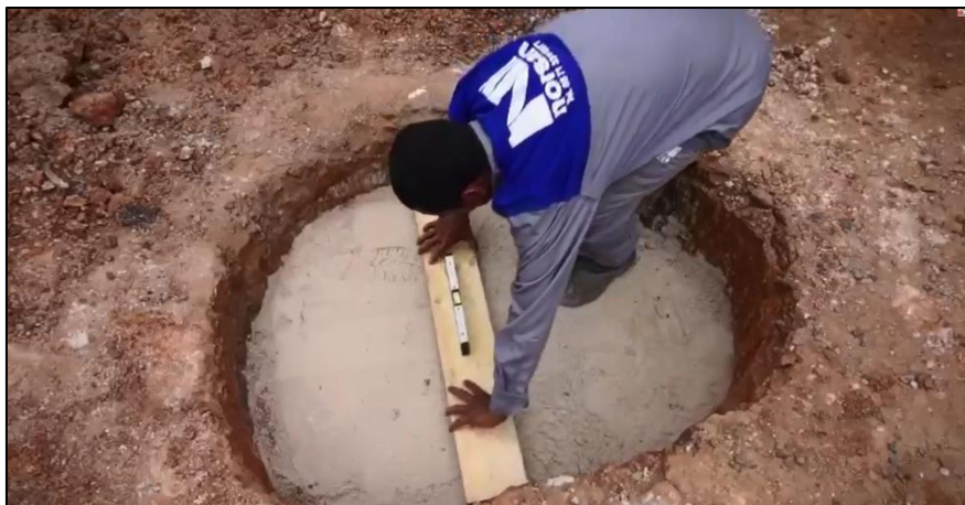
Nivelar o buraco com uma camada de areia.
