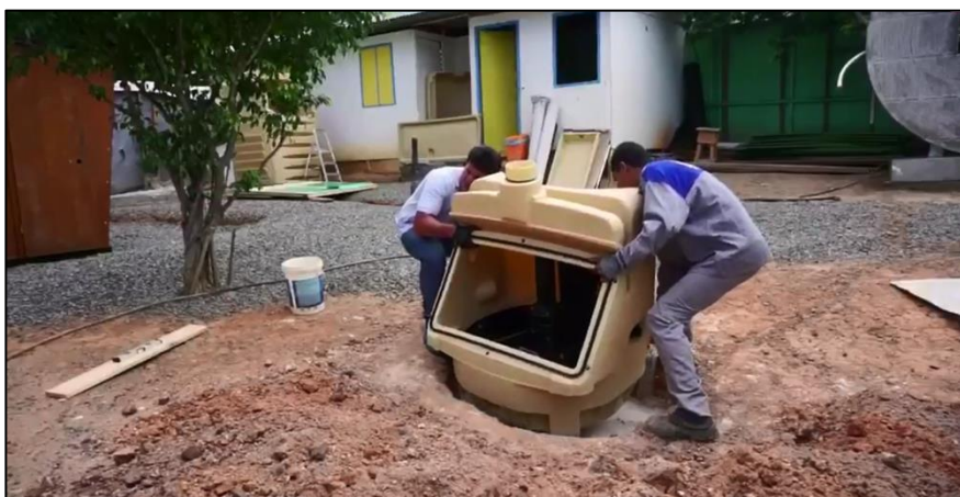
Colocar a unidade funcional em cima da camada.
