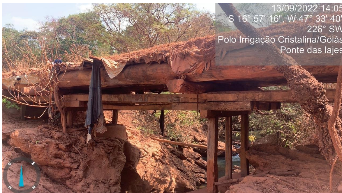
Figura 3 - Vista da Ponte existente – Ponte das Lajes.
