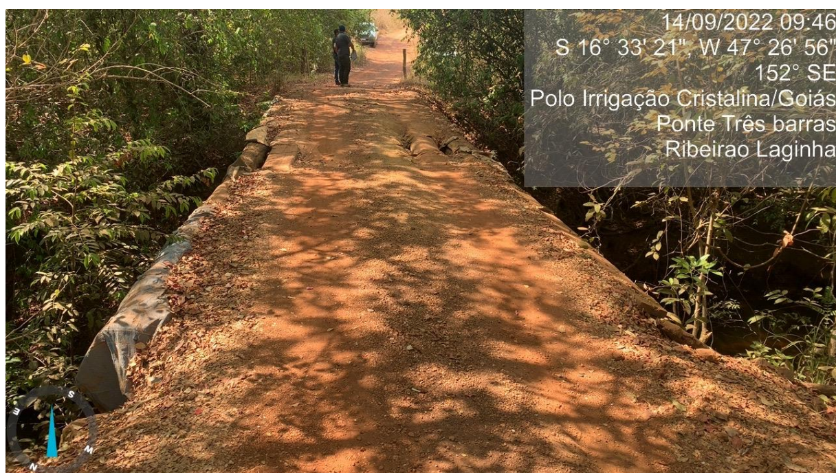
Figura 6 - Vista da Ponte existente – Fazenda Três Barras.
