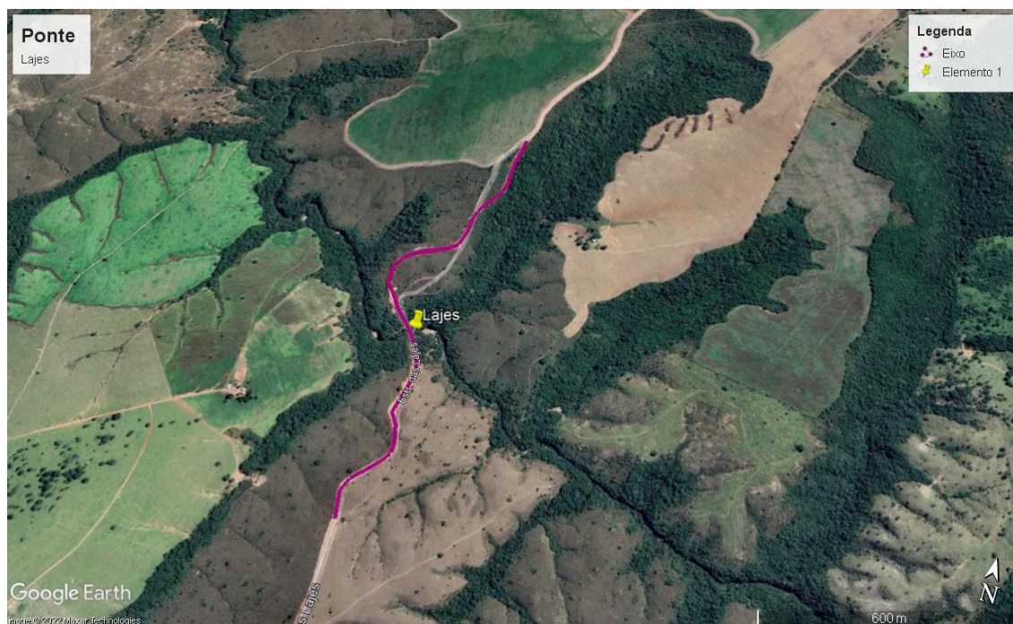
Figura 1 - Extensão do Levantamento Topográfico (1,5 Km) – Ponte das Lajes.
