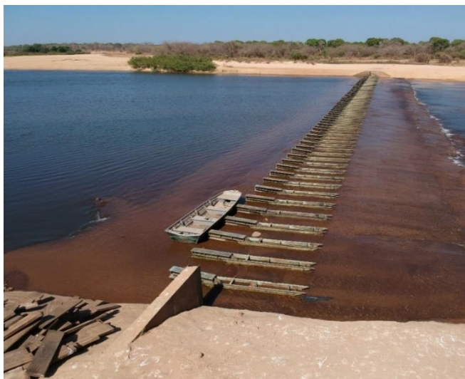
Figura 3 – Estrutura desmontada permitindo liberação da vazão.
