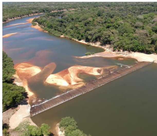
Figura 4 – Situação do rio após instalação da solução com manutenção do escoamento
