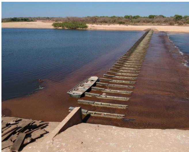
**Figura 3** – Estrutura desmontada permitindo liberação da vazão.
