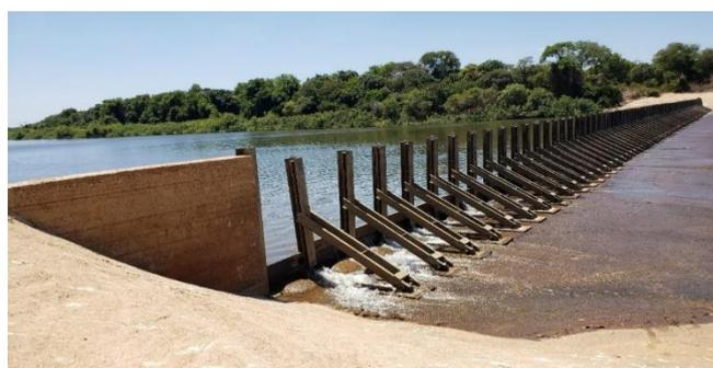
**Figura 2** – Método construtivo dos perfis metálicos articulados.
