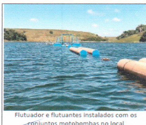
Ancoragem de bombas no flutuador
