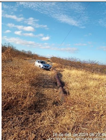
FOTO 23 – Sondagem não executada. Trecho com duas adutoras implantadas, mas apenas uma estava aparente. Risco de danificar a adutora enterrada.
