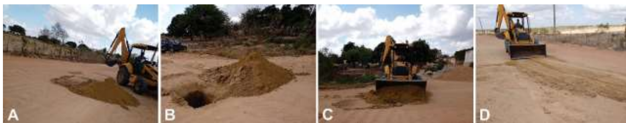
Figura 2.2 – Sequência ilustrativa dos procedimentos de abertura (fotos “A” e “B”) e fechamento (fotos “C” e “D”) das trincheiras.
