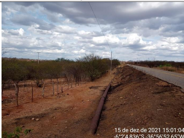
FOTO 22 – Sondagem não executada. Trecho com duas adutoras implantadas, mas apenas uma estava aparente. Risco de danificar a adutora enterrada.
