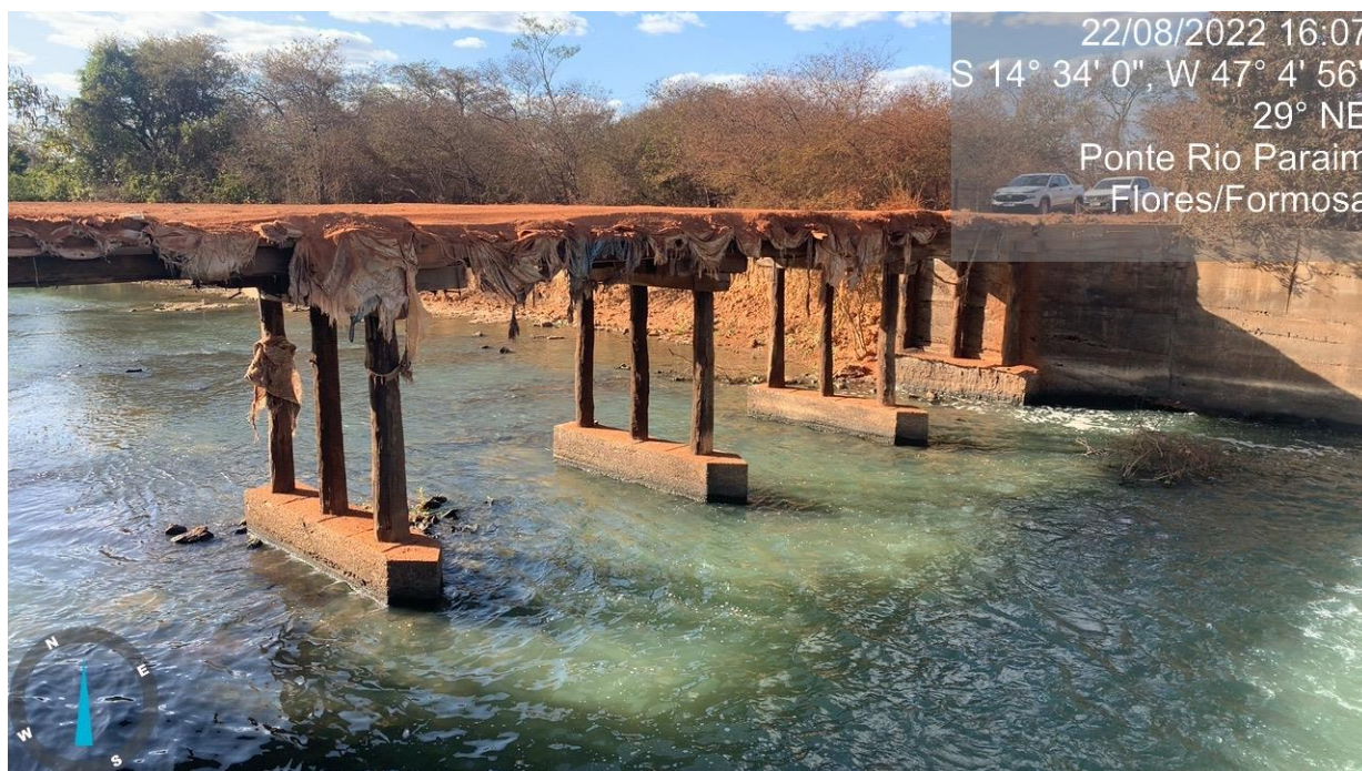
Figura 6 - Vista da Ponte existente - Rio Paraim.
