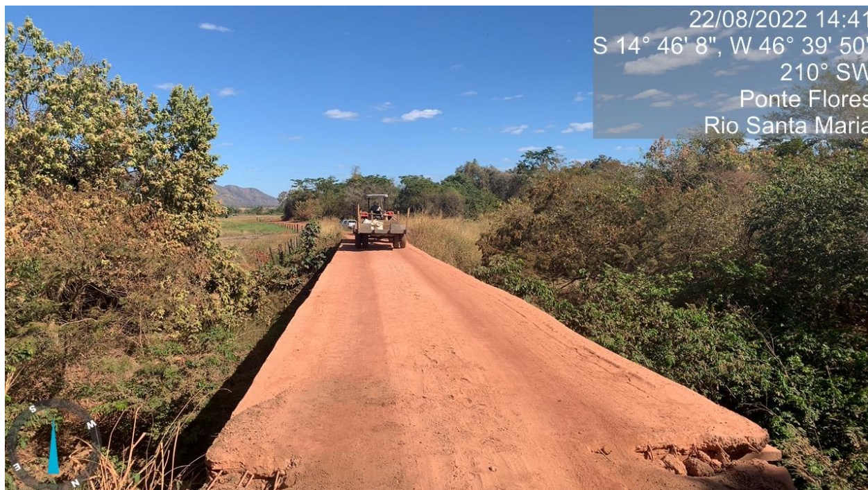
Figura 3 - Vista da Ponte existente - Assentamento Santa Maria.
