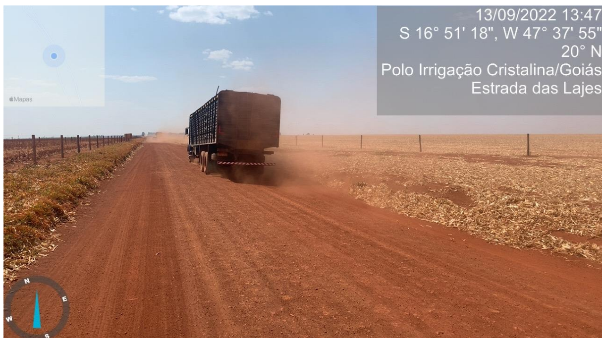
Figura 2 – Estrada das Lajes.
