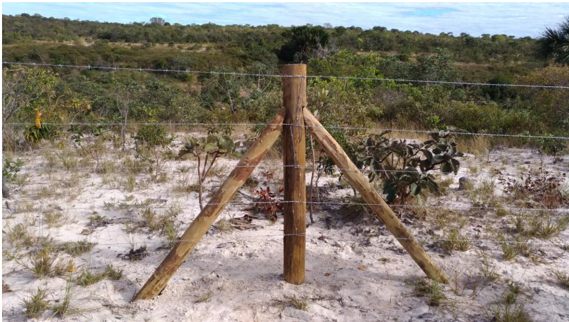
Modelo dos escoramentos dos esticadores
