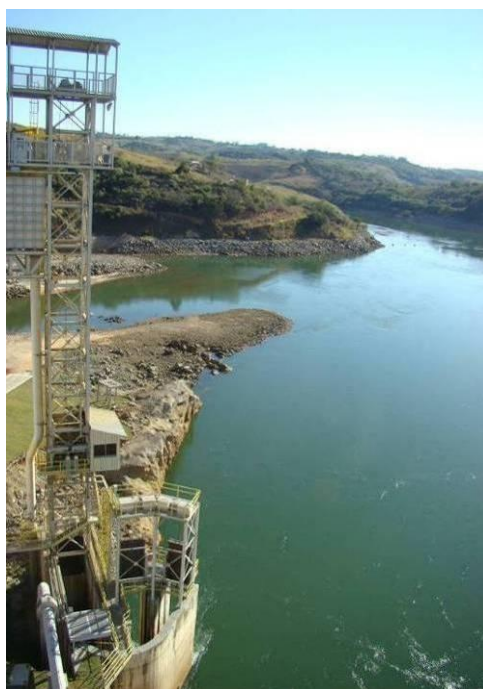
Foto 2 - Exemplo de elevador para peixes construído no rio Grande, na UHE Funil, Minas Gerais (Fonte: Arquivo Floram, 2007).
