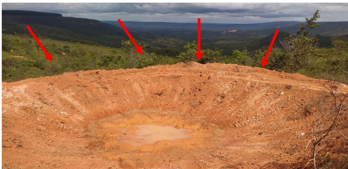
Figura 2: Demonstrando (setas) a execução do “cordão” de solo na parte de “fora” da crista da bacia de captação de enxurrada, com objetivo de escoamento de água no talude à jusante.
