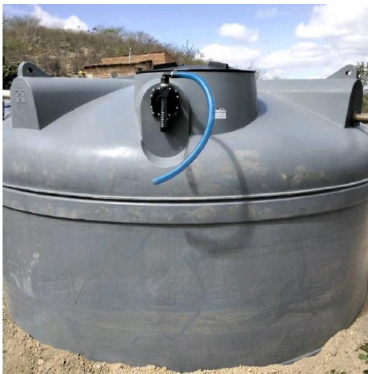
Figura 5: Exemplo de reservatório de 16.000L instalado.
