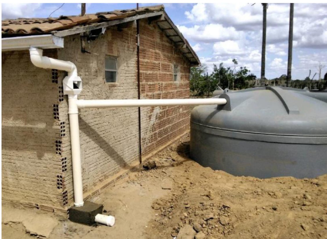
Figura 8: Visão geral da cisterna instalada.
