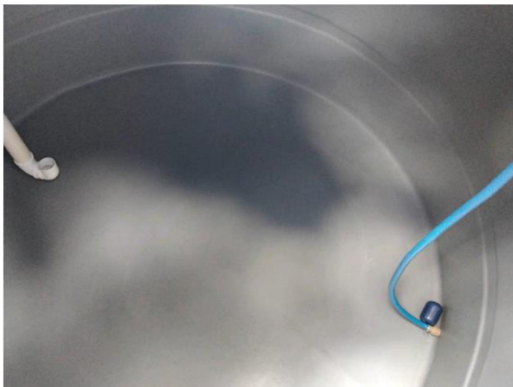
Figura 7: interior da cisterna após a instalação.
