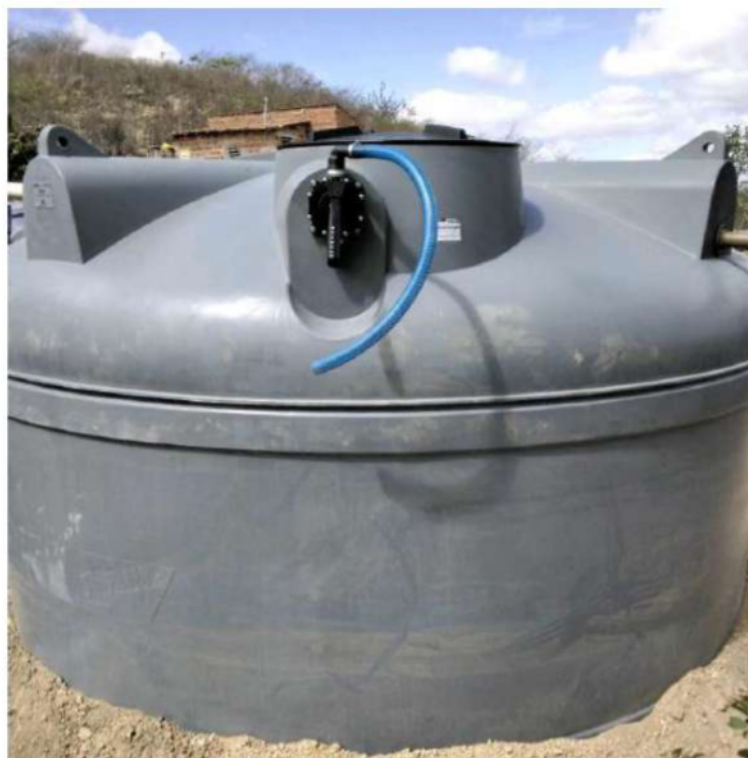
Figura 5: Exemplo de reservatório de 16.000L instalado.
