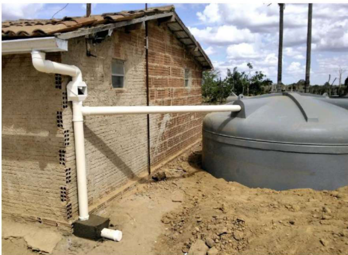
Figura 8: Visão geral da cisterna instalada.
